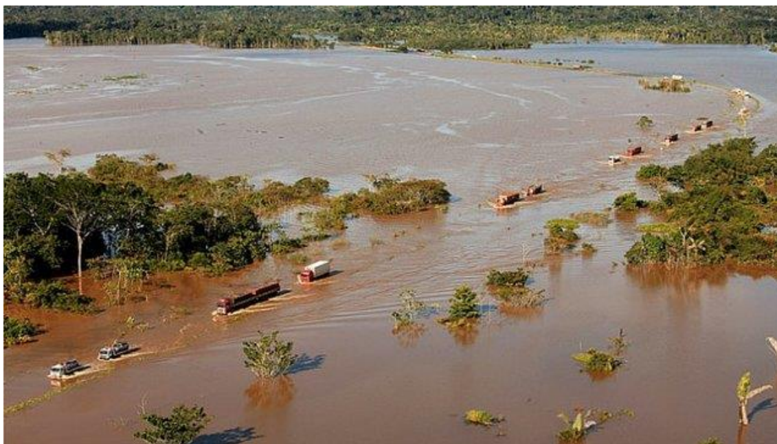
Figura 6. Cheia do rio Madeira afetando o tráfego na BR 364.
